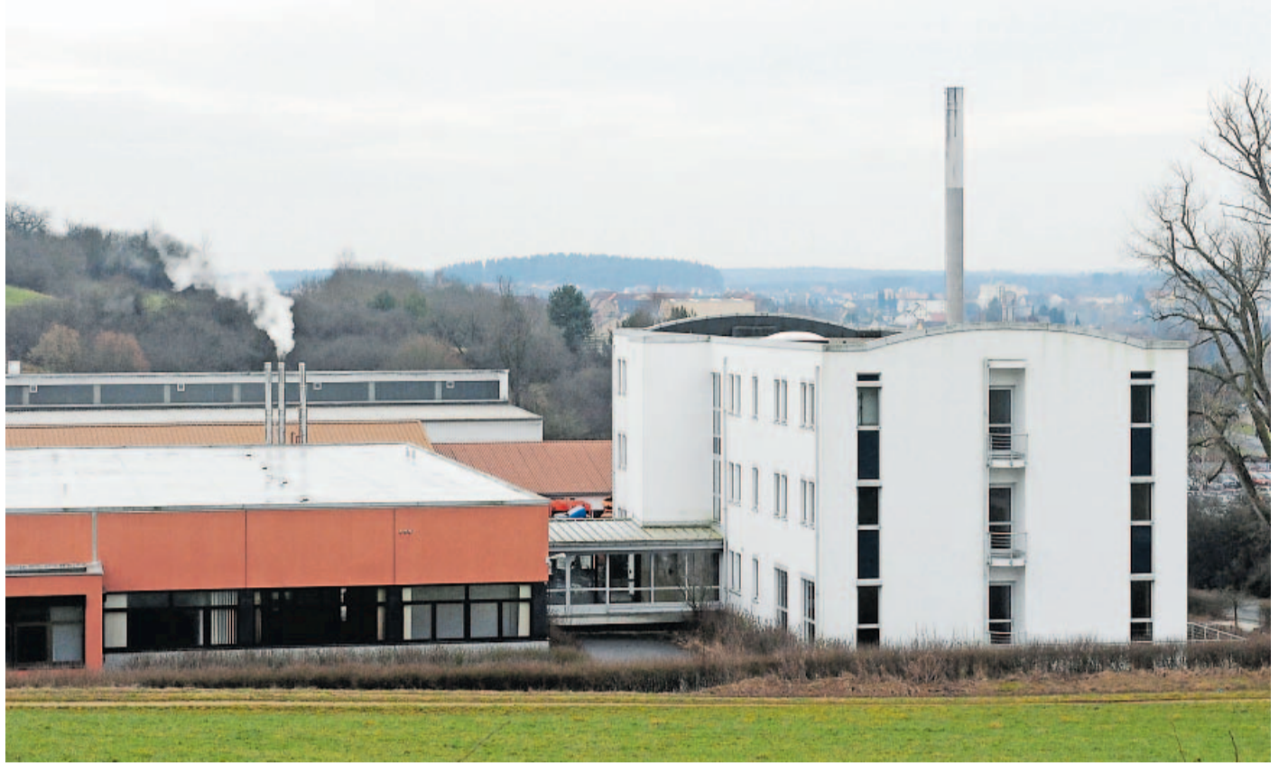
In diesem Gebäude wurde Pampolina-Kindermode entworfen, hergestellt und verschickt. Jetzt richtet vfm hier ein Zentrum für unabhängige Vermittler ein. Platz ist auch für die Pegnitzer Agentur für Arbeit, die bald aus dem PEP-Komplex ausziehen muss. Foto: Ralf Münch
