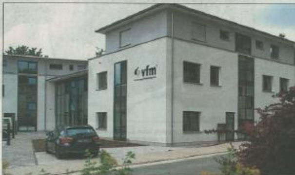
Die Büroräume des modernen vfm-Dienstleistungszentrums sind bereits komplett ausgelastet beziehungsweise vermietet. Fotos: Trezz
